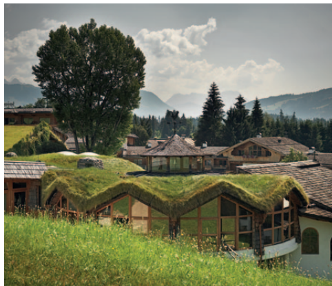
Aus baubiologischen Gründen gibt es beim Stanglwirt nur Gras- und Schindeldächer.
